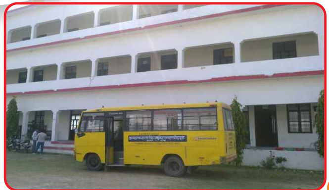
जगदम्बा शरण सिंह एजुकेशनल इंस्टीट्यूट, बेलसर-गोण्डा
